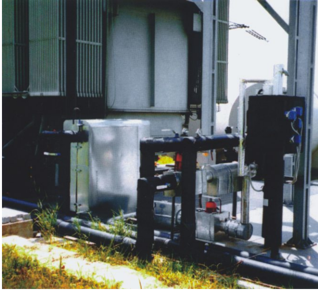
Vytápění administrativní budovy teplem z oleje trafa - JME rozvodna Čebín
