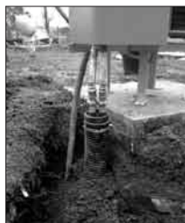
Propojení kompenzátorů vibrací s předizolem
